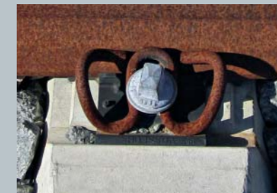
Kleinteil zur Befestigung von Schienen (Stahl)
